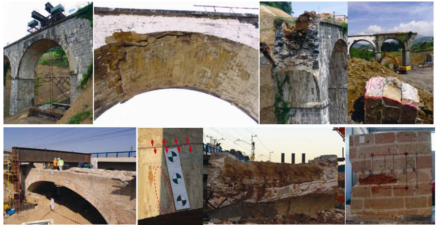
Fig. 1. Arriba. puente de Urnieta. Abajo, puente de la Riera de Rubí (de izquierda a derecha). Sistema de aplicación de carga, daños durante el ensayo, reconocimiento de morfología interna durante la demolición, extracción de muestras y ensayos a probetas.
