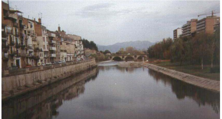
Figura 2. Lugar de emplazamiento de la obra
