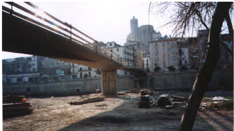
Figura 6. Vista inferior de la pasarela en construcción.
