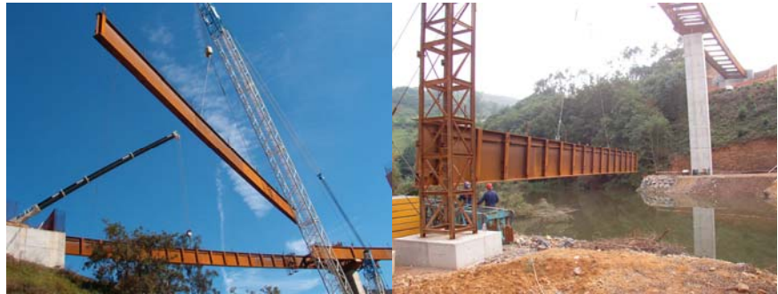
Figura 7 Izq. Viaducto Nora 2. Izado de una viga en vano extremo. Der. Viaducto Nora 2. Izado de una viga en vano central.
