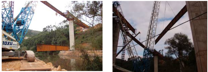
Figura 13. Montaje del último vano. Viga 2.
