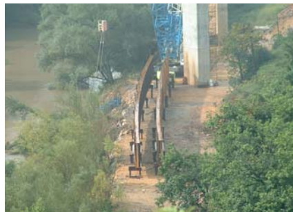
Figura 8. Viaducto Nora 2. Vigas de 80 metros de longitud del vano central
