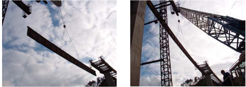
Figura 12. Montaje del último vano. Viga 1.
