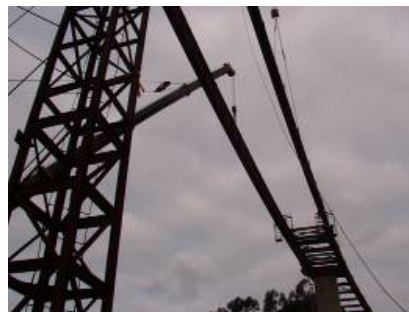
Figura 14. Montaje del último vano. Vigas independientes sujetas mediante las grúas.
