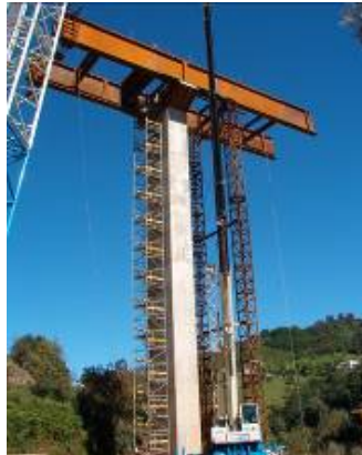
Figura 10. Primer tramo sobre pila
