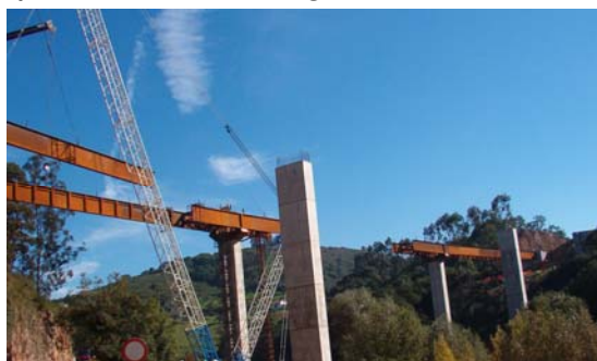
Figura 11. Montaje del último vano.
