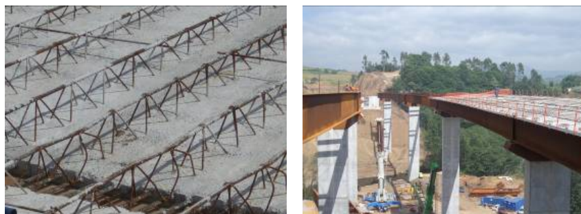
Figura 4. Viaducto Nora 1. Detalles de la prelosa
