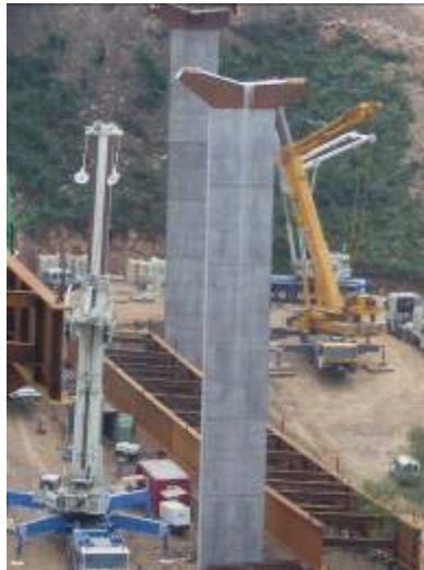
Figura 5. Viaducto Nora 1. Aspecto de la pila con dintel metálico.
