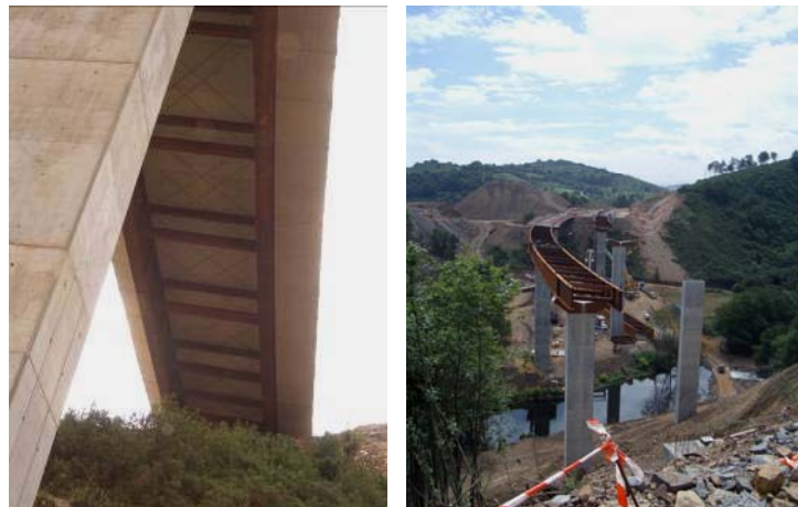
Figura 1. Viaducto Nora 1. Vistas inferior y superior durante la construcción
