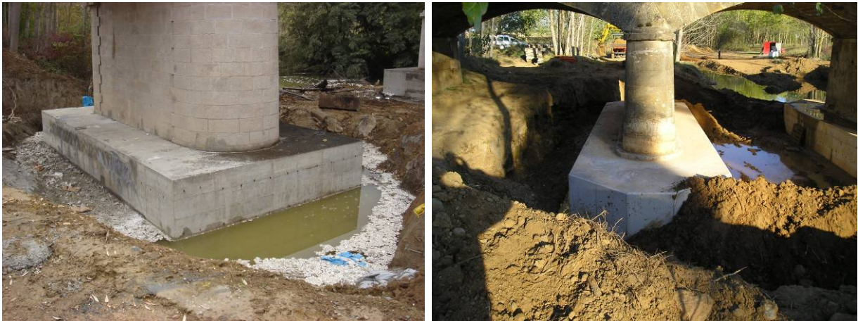
Fig 2. Vista de los zunchos ya construidos.
