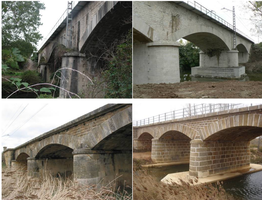
Fig 1. Vista general de las estructuras antes y después de la reparación
