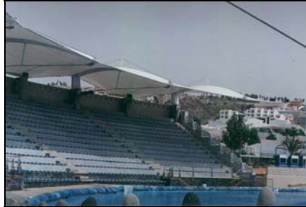
Cubierta en material compuesto: Delfinario de Tenerife
