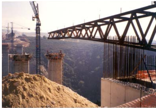
Procedimiento de empuje puente sobre el río Sil
