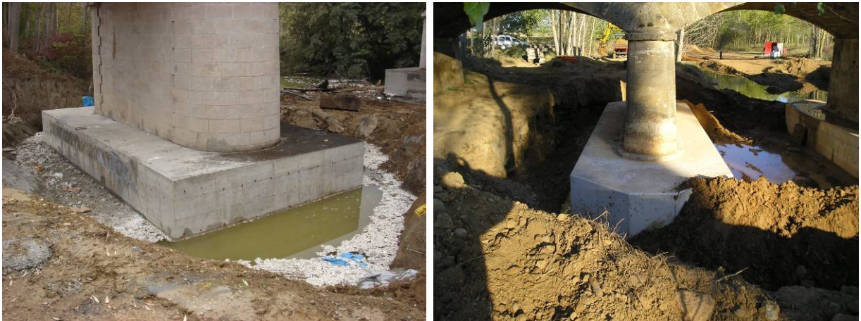
Fig 2. Vista de los zunchos ya construidos.
