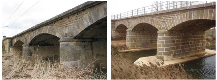
Fig 1. Vista general de las estructuras antes y después de la reparación.
